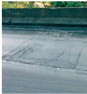
(d) Trinca de retração (TRR)
