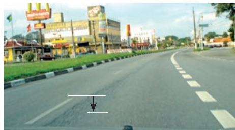
(d) Recalque diferencial
