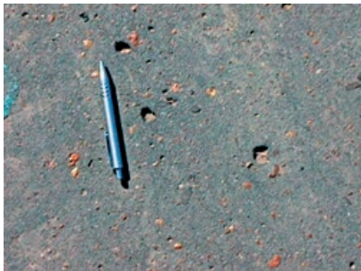
(c) Deslocamento e perda de agregados
