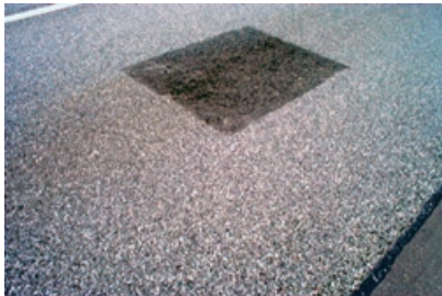
(d) Remendo bem executado (R)
