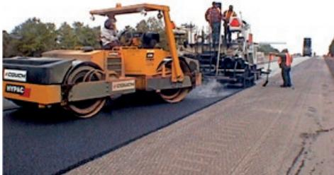
Figura 8.26 Exemplo de rolo vibratório
