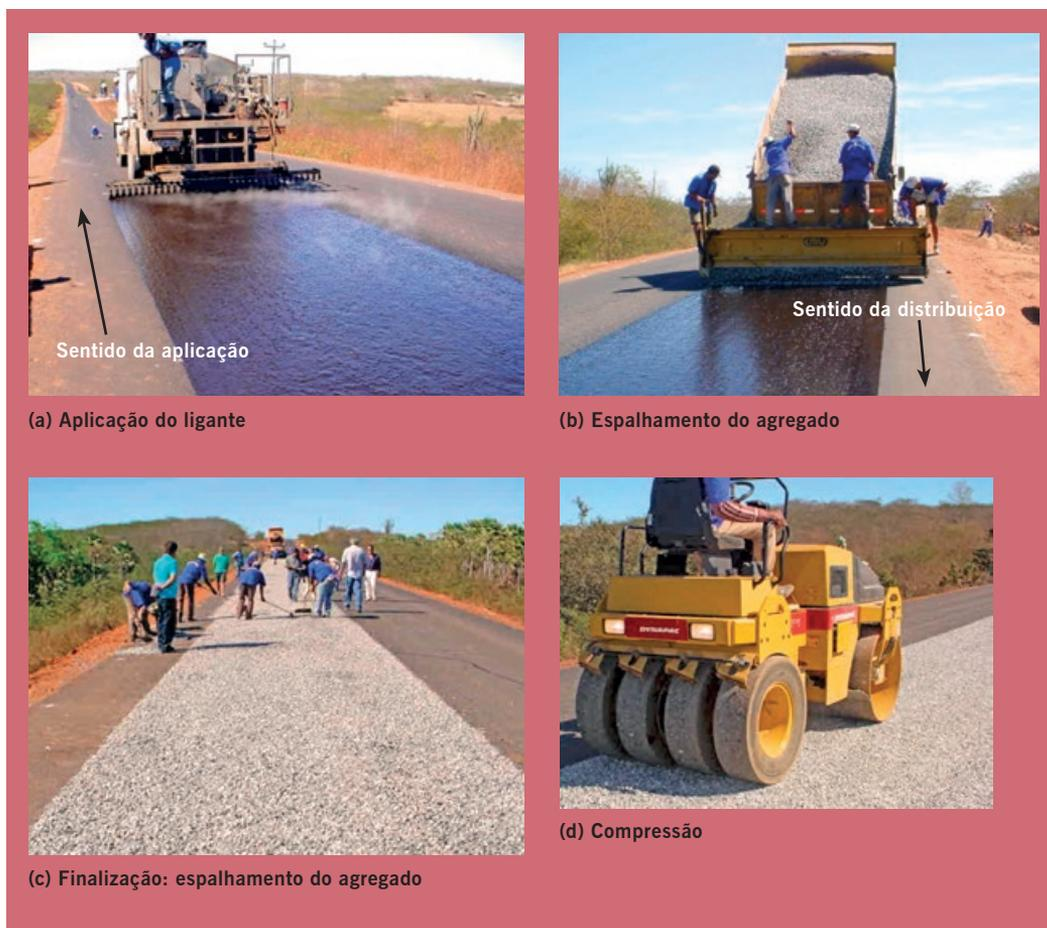
**Figura 8.31 Exemplo das etapas de construção de um tratamento superficial**
