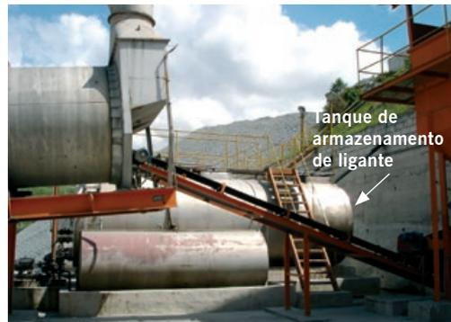
Figura 8.6 Exemplo de tanques horizontais para armazenamento com aquecimento de ligantes asfálticos de uma usina gravimétrica
