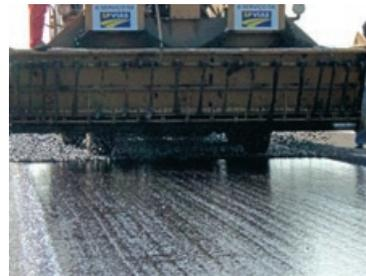
(d) Detalhe da distribuição de agregado
