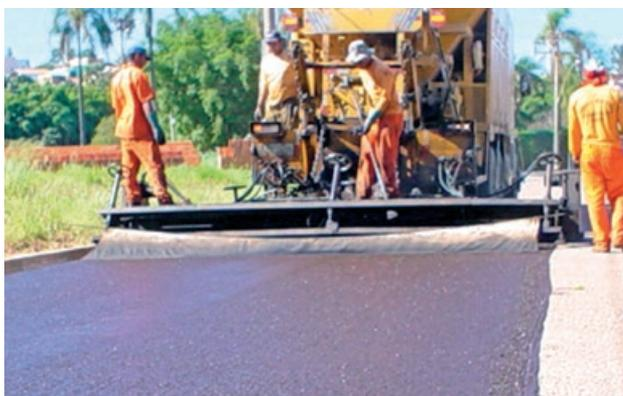
**Figura 8.36 Exemplos de aplicação de lama asfáltica**
