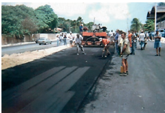
(b) Revestimento asfáltico sendo executado
