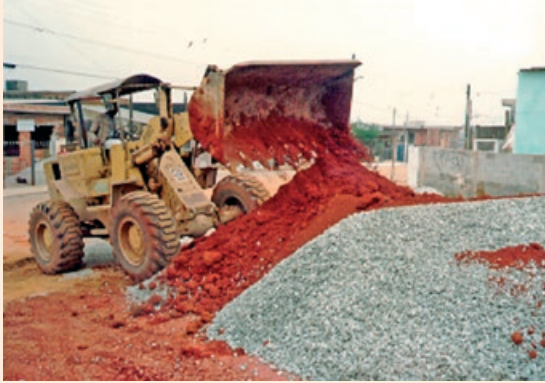
(a) Solo-brita descontinuo: mistura em pista
