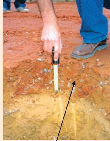
(a) Solo-brita descontinuo: detalhe da camada compactada
