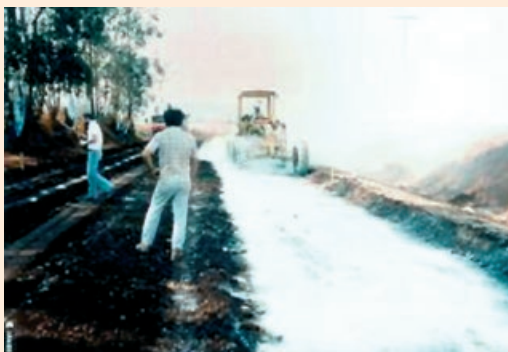
(e) Solo-cal: mistura em pista
