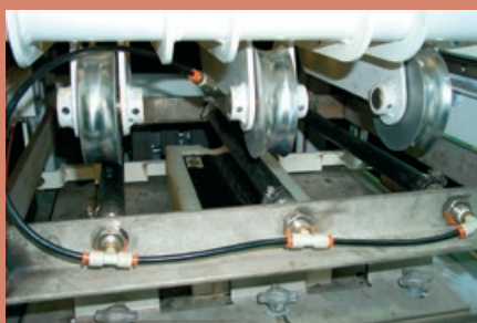
(c) Carregamento sobre placa por meio do mangote
