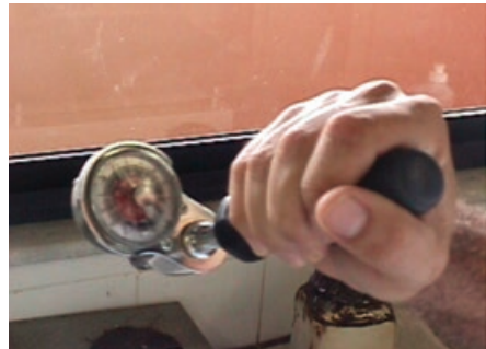
(c) Verificação do torque
