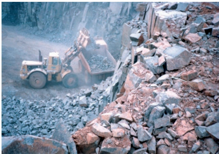
Figura 3.4 Carregamento de um caminhão na pedreira
