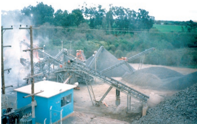
Figura 3.6 Vista geral de uma instalação de britagem
