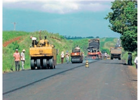
(h) Execução da camada de reapecamento
