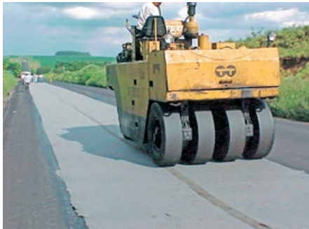
(e) Compressão para a aderência à pintura de ligação
