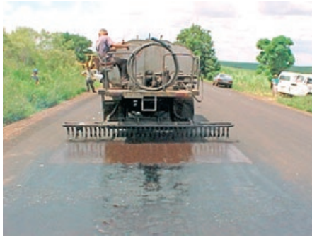
(a) Execução da pintura de ligação
