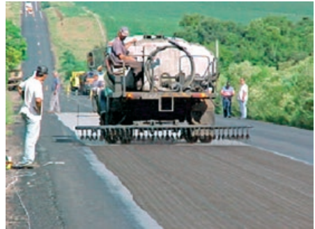
(f) Impregnação com emulsão asfáltica
