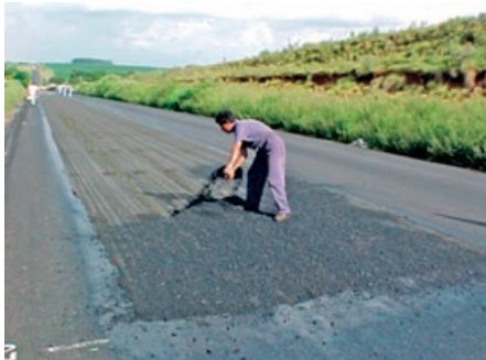
(g) Espalhamento de pedrisco impregnado com ligante asfáltico
