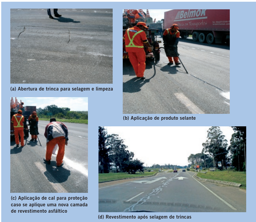
Figura 11.2 Exemplo de selagem de trincas
