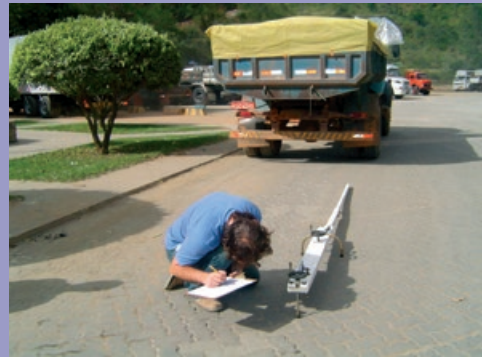
(c) Afastamento do caminhão e leitura final
