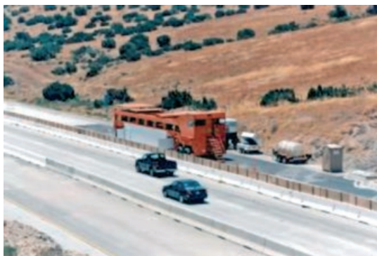
(b) Teste em faixa adicional ao lado da pista existente
