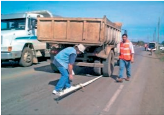
(b) Medida com viga Benkelman em campo
