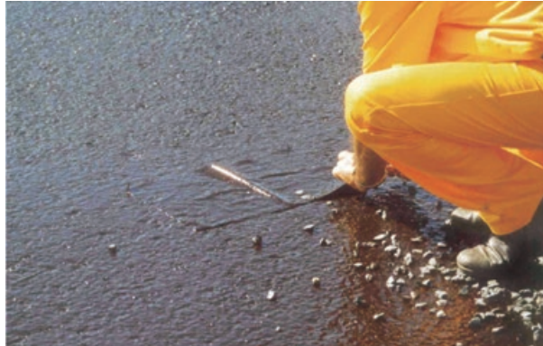
Figura VI.5 – Determinação da taxa de pintura de ligação
