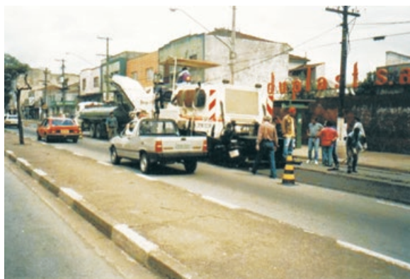
Figura XVII.3 – Reciclagem a frio no local, em via urbana
