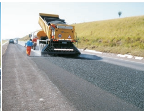
(b) aplicação simultânea de emulsão e agregado
