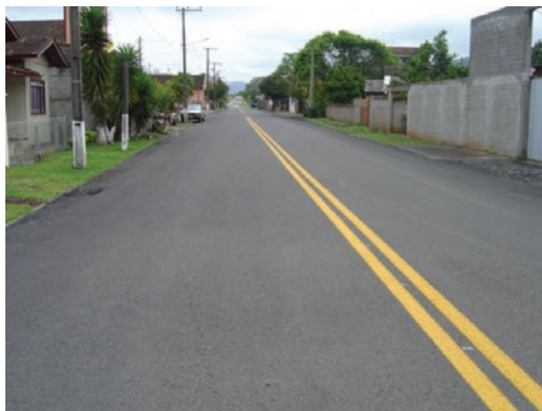
Figura XIII.5 – Revestimento asfáltico tipo PMF em via urbana
