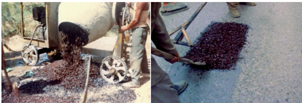
(a) preparação do PMF em betoneira
