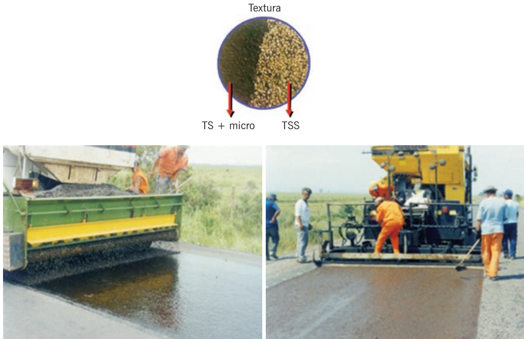
Figura XI.1 – Execução do cape seal – aplicação conjunta de TS e MRAF
