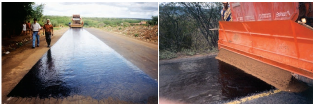
(a) aplicação de emulsão asfáltica
