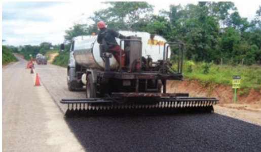
Figura VII.3 – Aplicação da taxa de emulsão asfáltica com caminhão espargidor
