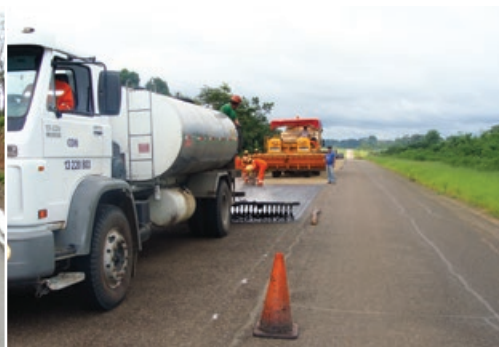
Figura VII.6 – Tratamento superficial executado em rodovia
