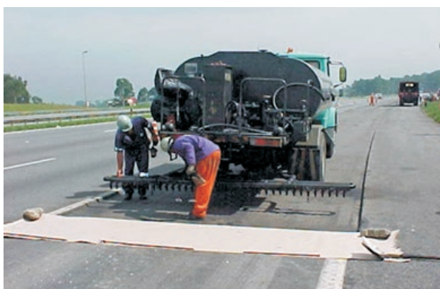
Figura VI.4 – Colocação de faixas de papel não poroso para pintura de ligação
