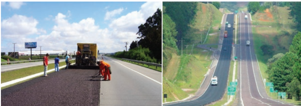
Figura X.4 – Aplicação de microrrevestimento asfáltico em rodovia de alto tráfego
