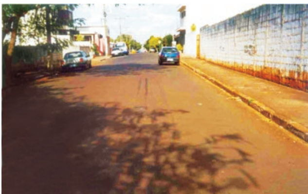
Figura XII.1 – Macadame betuminoso com capa selante em via urbana. Execução: 1993
