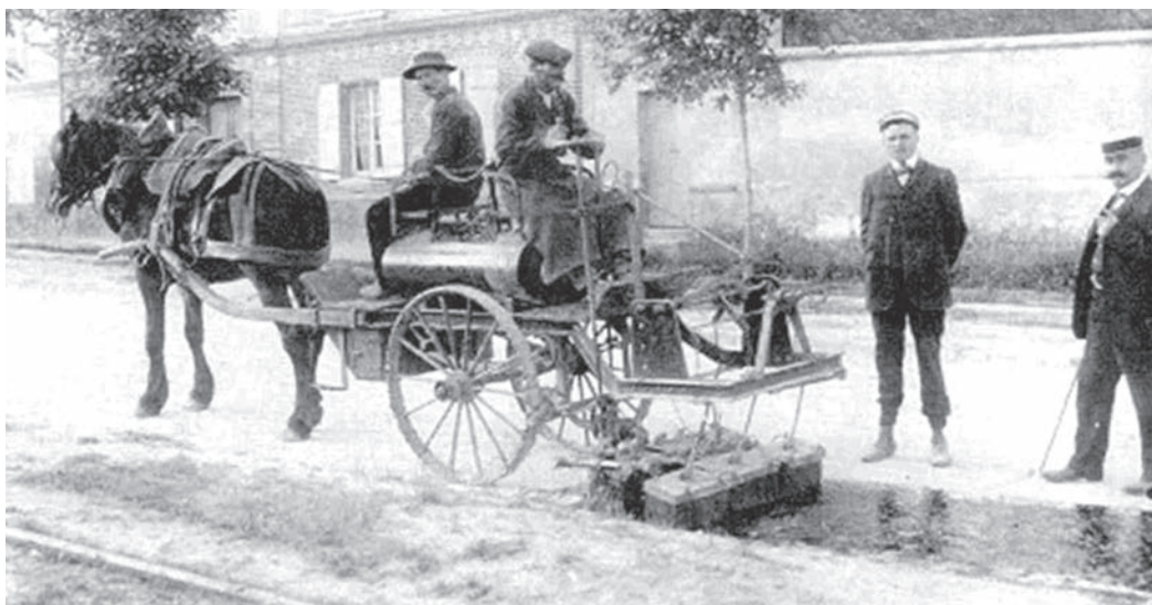
Figura IV.1 – Aplicação de emulsão asfáltica no início do século passado
