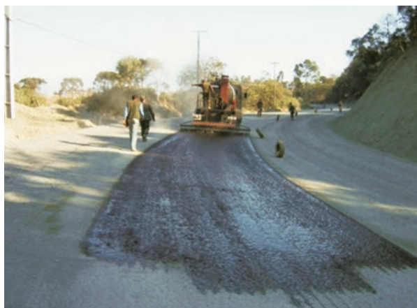
Figura V.1 – Aplicação da emulsão tipo EAI
