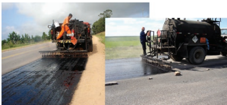
Figura VI.3 – Aplicações de pintura de ligação com caminhão espargidor
