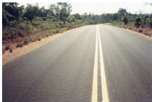
Figura VIII.2 – Aspecto final do tratamento para eliminação de poeira
