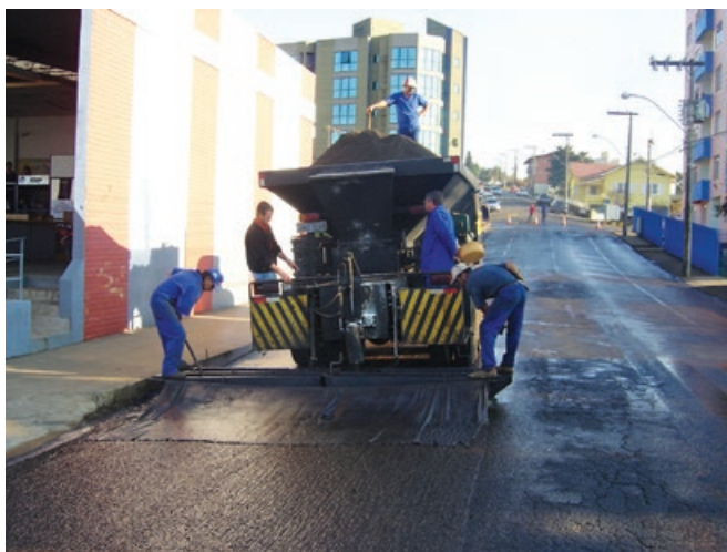
Figura IX.1 – Aplicação de lama asfáltica
