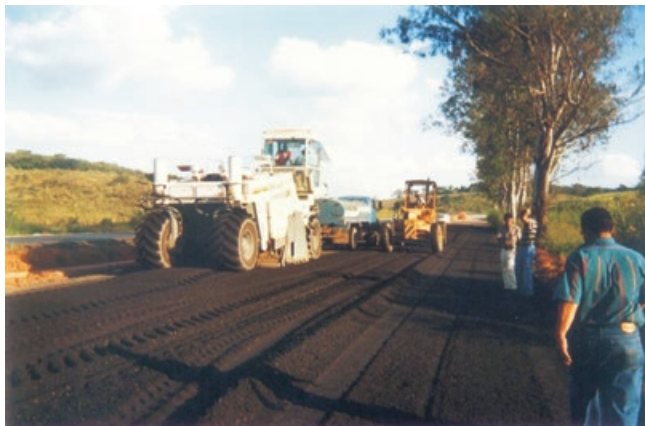
Figura XVI.1 – Estabilização de solos no local, com emulsão asfáltica
