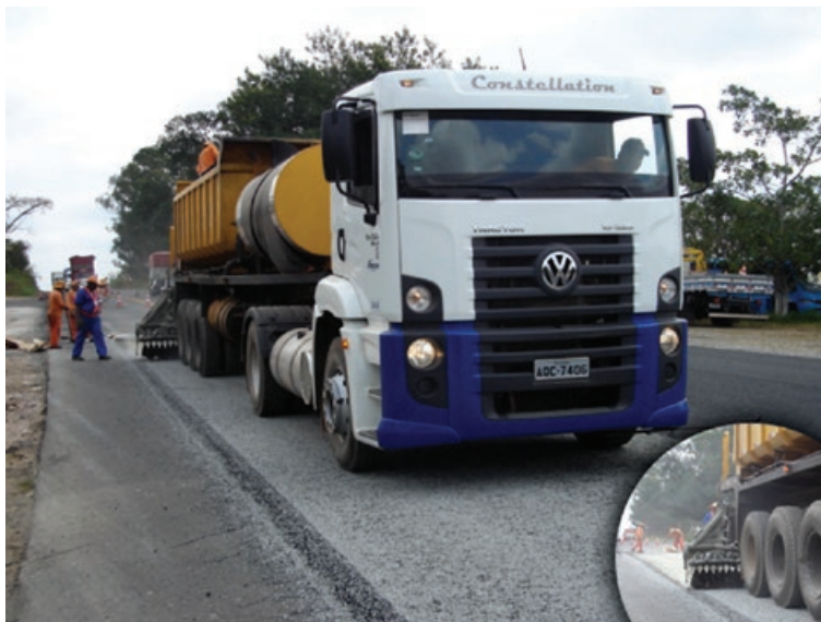
Figura VII.8 – Aplicação simultânea de emulsão asfáltica elastomérica e agregados através do equipamento multidistribuidor
