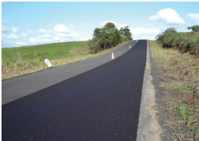
Figura X.5 – Aplicação de microrrevestimento asfáltico em rodovia rural
