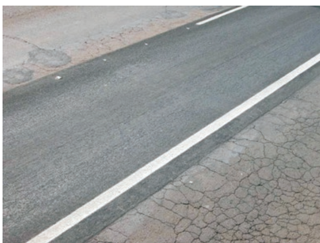
Figura XVII.5 – Detalhe da reciclagem a frio em seção do pavimento da SP-333
