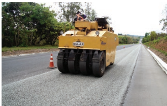
Figura VII.5 – Acomodação do tratamento superficial com rolo pneumático
