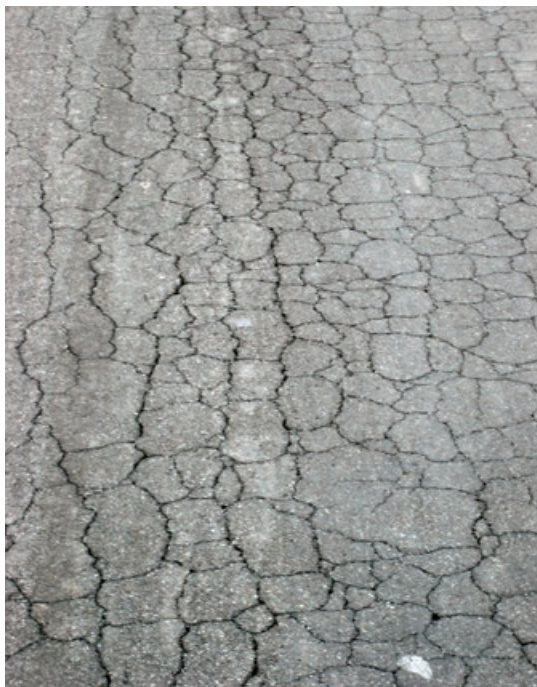
Figura X.1 – Pavimento asfáltico a ser restaurado (fresagem e recomposição) antes da aplicação de microrrevestimento
