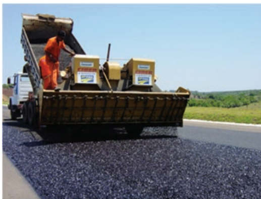
Figura VII.2 – Distribuidor de agregado para tratamento superficial
