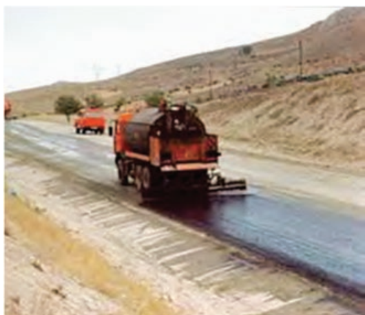
(a) aplicação da EAI sobre base granular Figura V.2 – Serviço de imprimação com EAI
