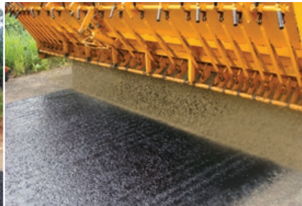
Figura VII.4 – Aplicação da taxa de agregado com distribuidor
