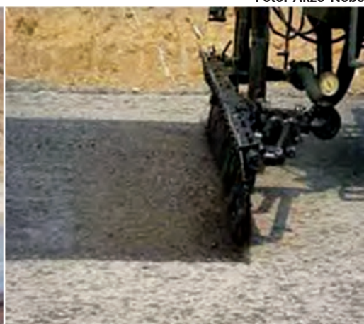
(b) detalhe da textura da base sendo imprimada
