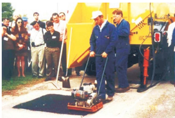
Figura XIV.2 – Compactação de tapa-buracos
