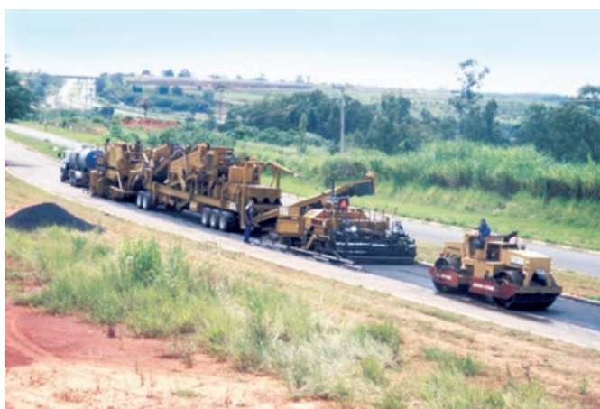
Figura XVII.4 – Reciclagem a frio no local, em rodovia
