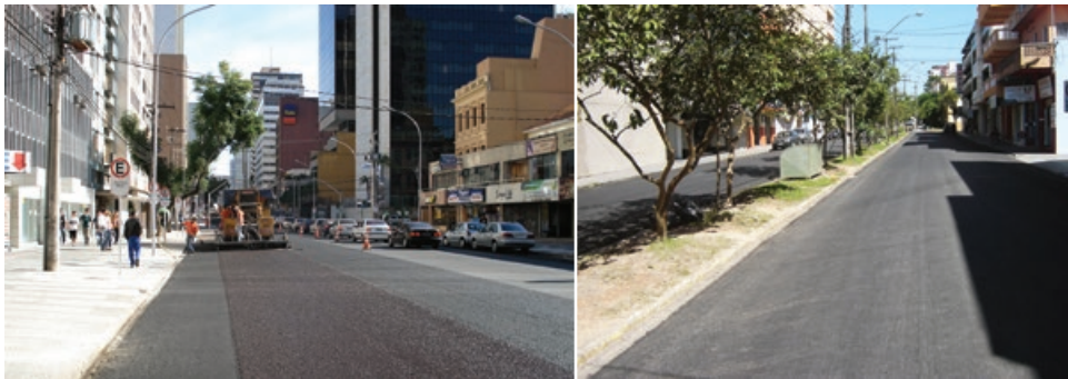
Figura X.7 – Microrrevestimento asfáltico a frio em vias urbanas
