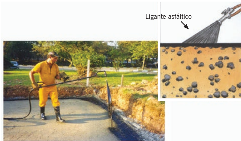
Figura VI.2 – Aplicação de pintura de ligação com caneta espargidora
