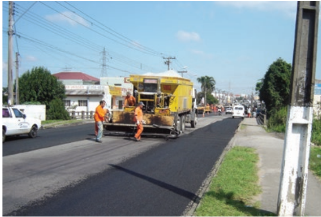
Figura X.6 – Aplicação de microrrevestimento asfáltico em via urbana expressa
