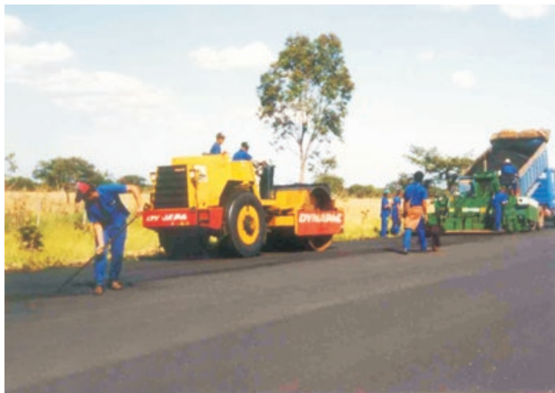
Figura XIII.4 – Aplicação de PMF denso com vibroacabadora
