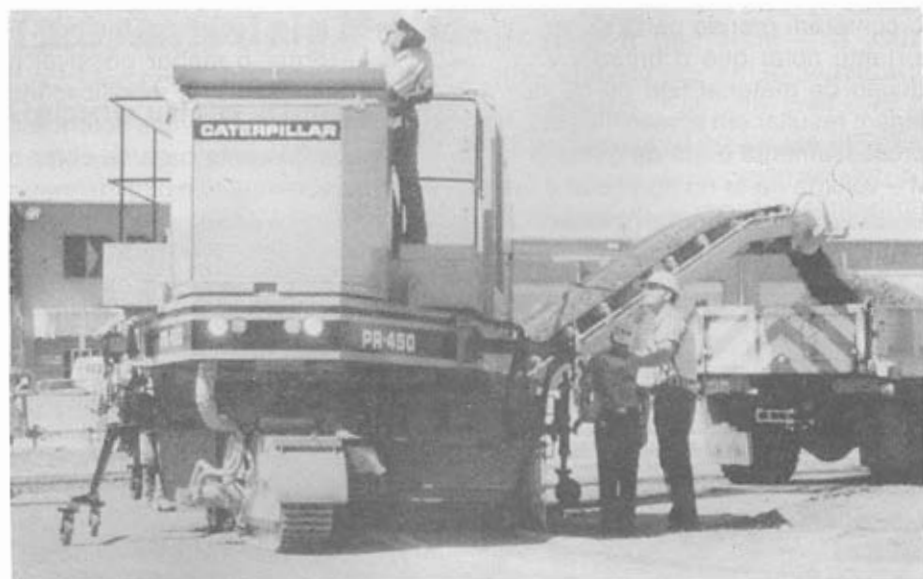
Figura 12.5 Fresagem a Frio (Cortesia de Caterpillar Tractor Co.)
