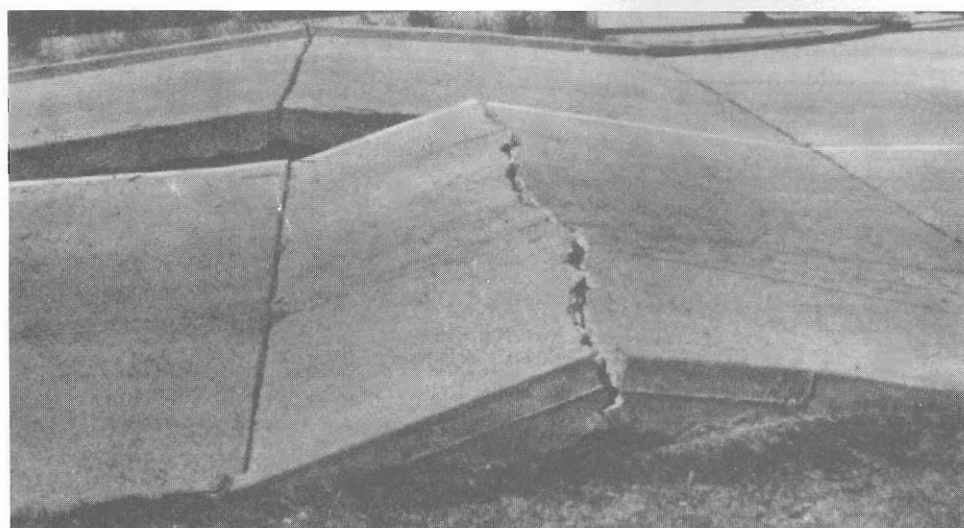
Figura 9.35 Arrebentamentos.
