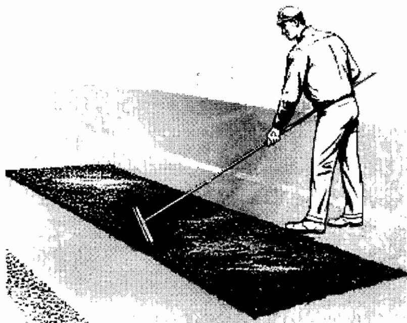
Figura 9.6 Espalhamento da Mistura.
