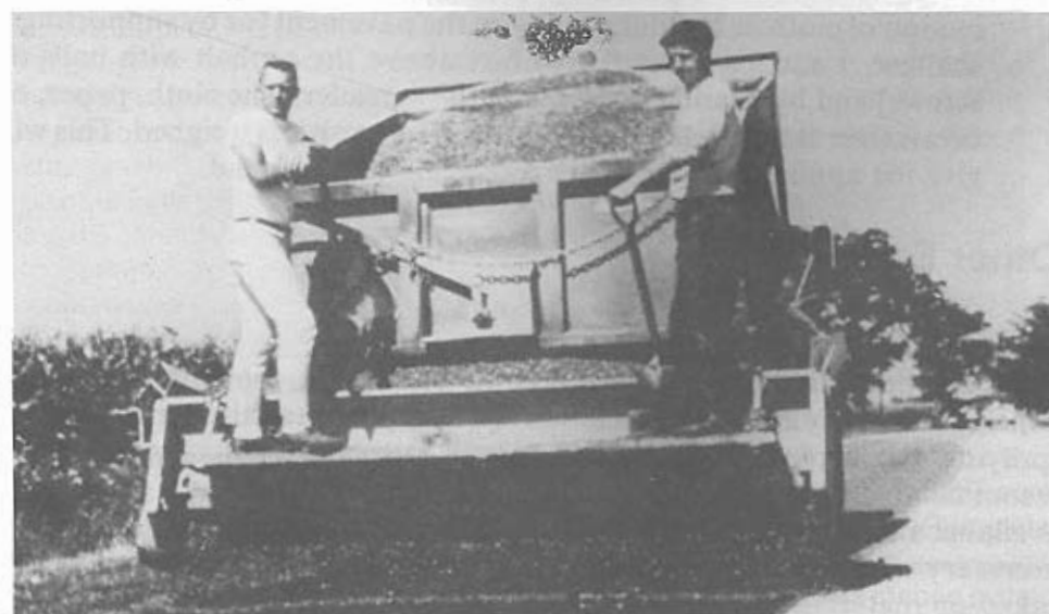
Figura 8.7 Espalhador Mecânico Preso a Caminhão.
