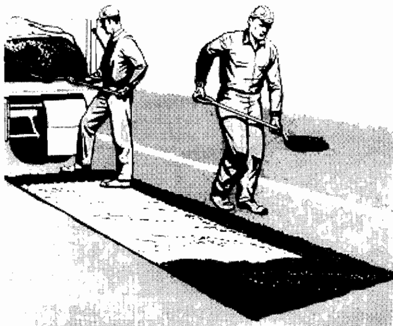
Figura 9.5 Preenchimento da Escavação com Mistura Asfáltica.
