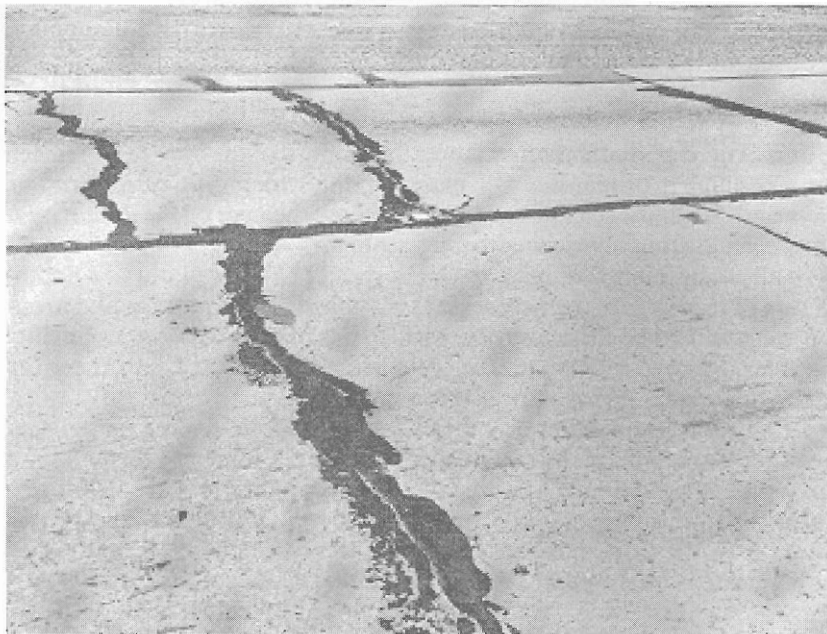
Figura 9.28 Trincas Transversais
