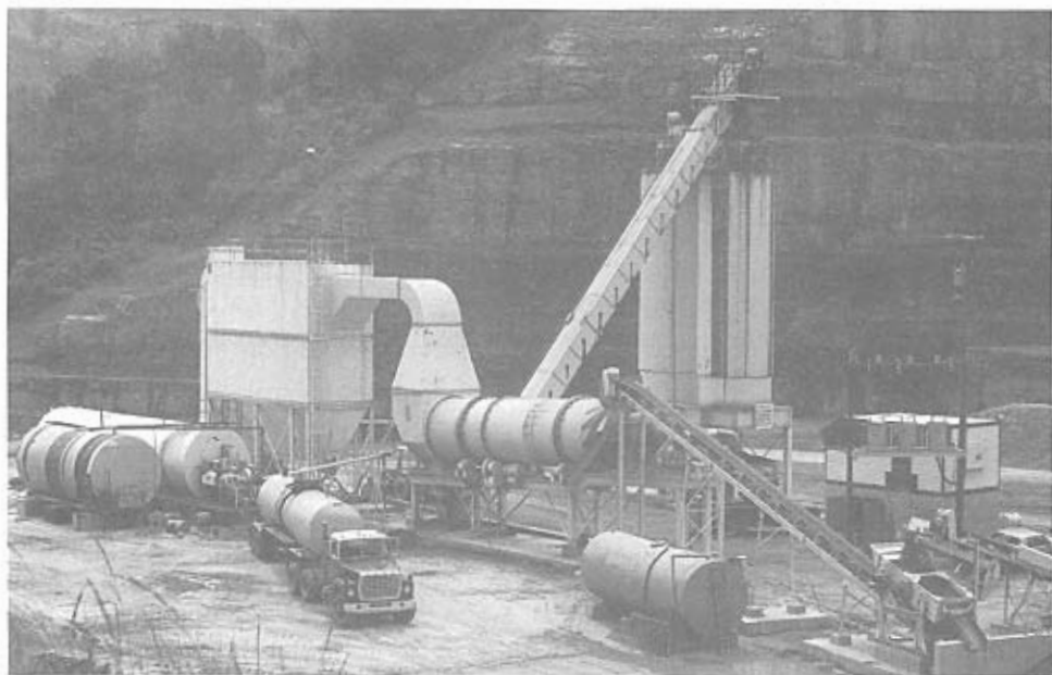
Figura 5.20 Instalação de Misturador de Tambor (Drum Mixer)
