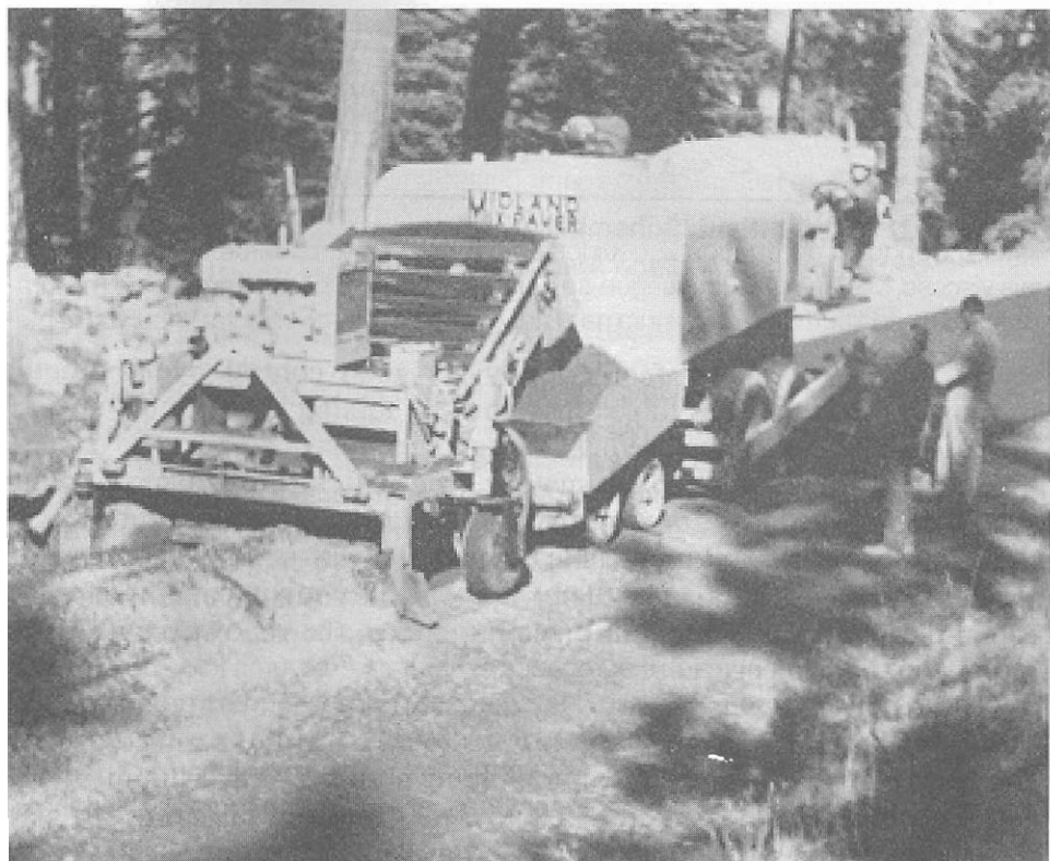
Figura 13.4 Usina Móvel do Tipo Tremonha
