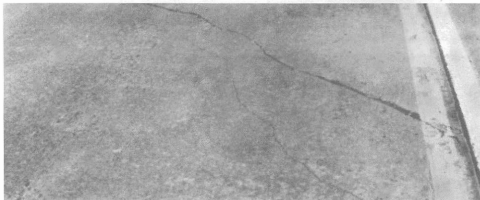
Figura 9.30 Trincas Diagonais.
