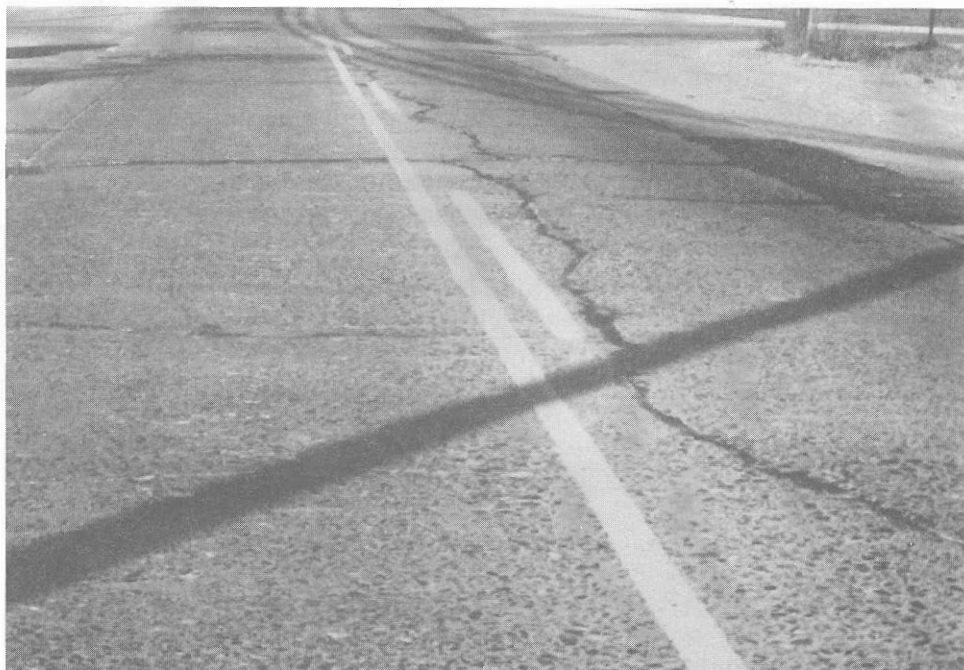
Figura 9.29 Trincas Longitudinais.
