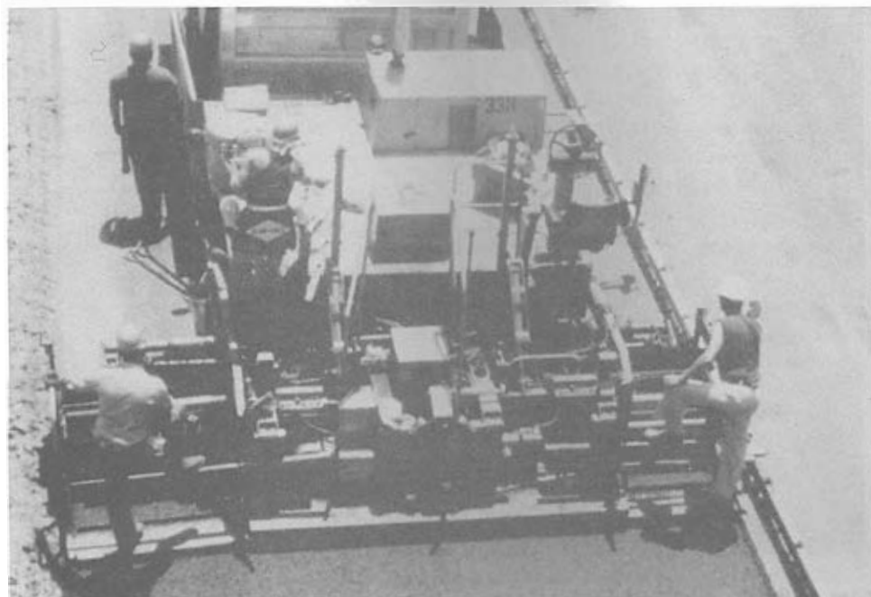
Figura 6.11 Seguidor de Greide de Corda. A Corda Esticada Também é Usada Como Guia do Operador da Pavimentadora.
