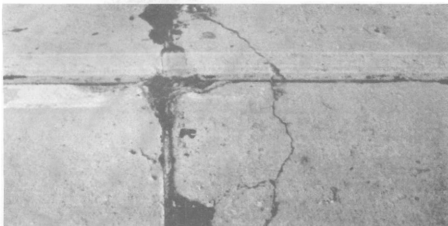
Figura 9.31 Trinca de Canto e Lascado.
