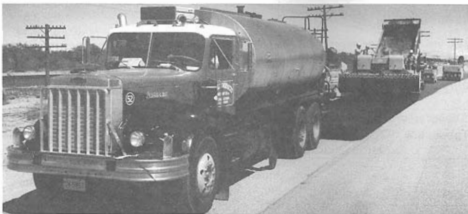
Figura 8.10 Operação de Tratamento Superficial (Cortesia de E. D. Etnyre Co.)
