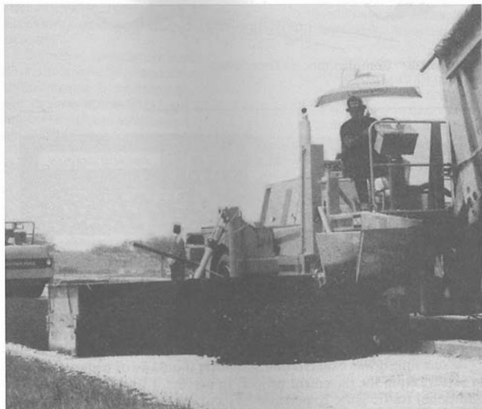
Figura 6.25 Base de Concreto Asfáltico Aplicado com Acabadora Especial Para Alargamento de Rodovias
