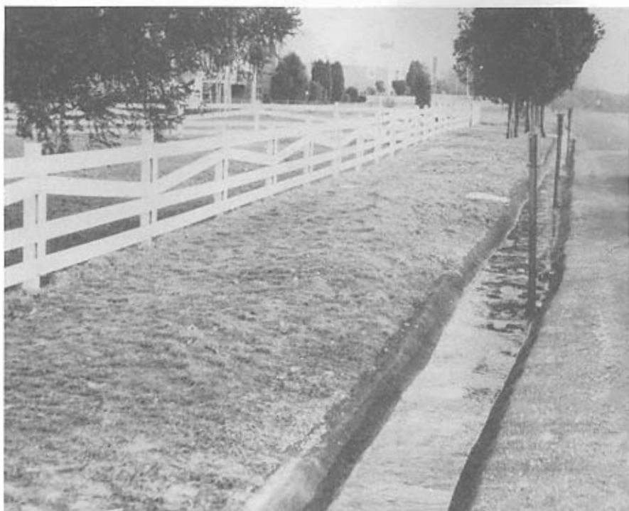
Figura 10.18 Pavimentação das Valetas Laterais Evita Erosão das Valetas.
