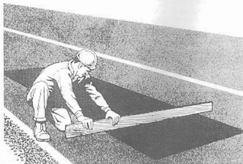
Figura 9.8 Verificação da Superfície Remendada com uma Régua
