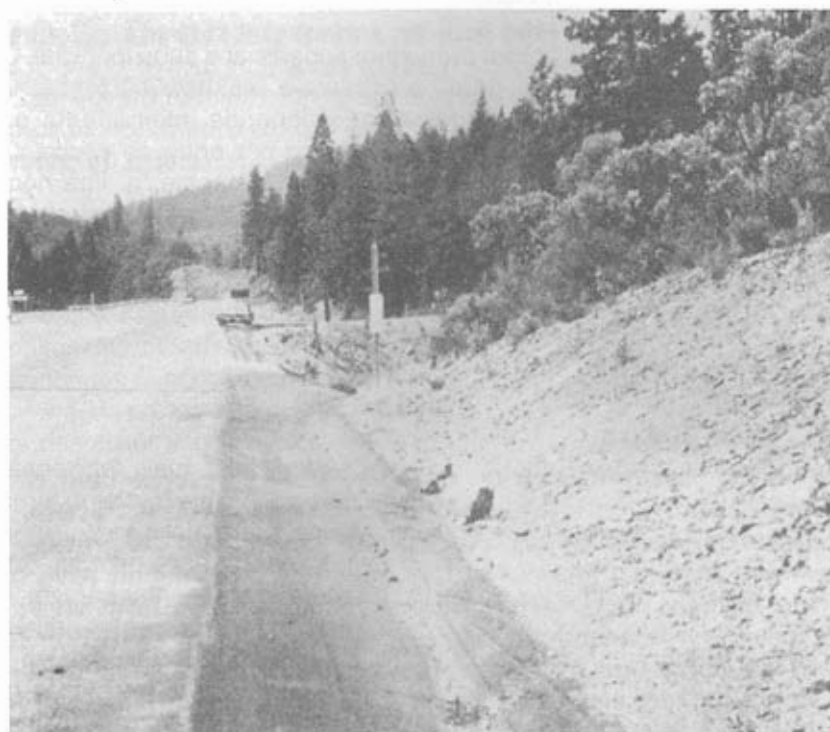
Figura 10.17 Valeta Lateral Típica.
