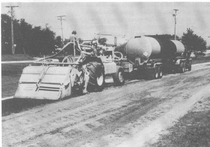
Figura 13.3 Misturador Rotativo, Tipo Pulvemisturador
