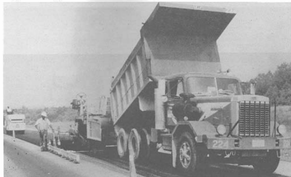
Figura 6.1 Mistura Asfáltica a Quente sendo Despejada na Acabadora
