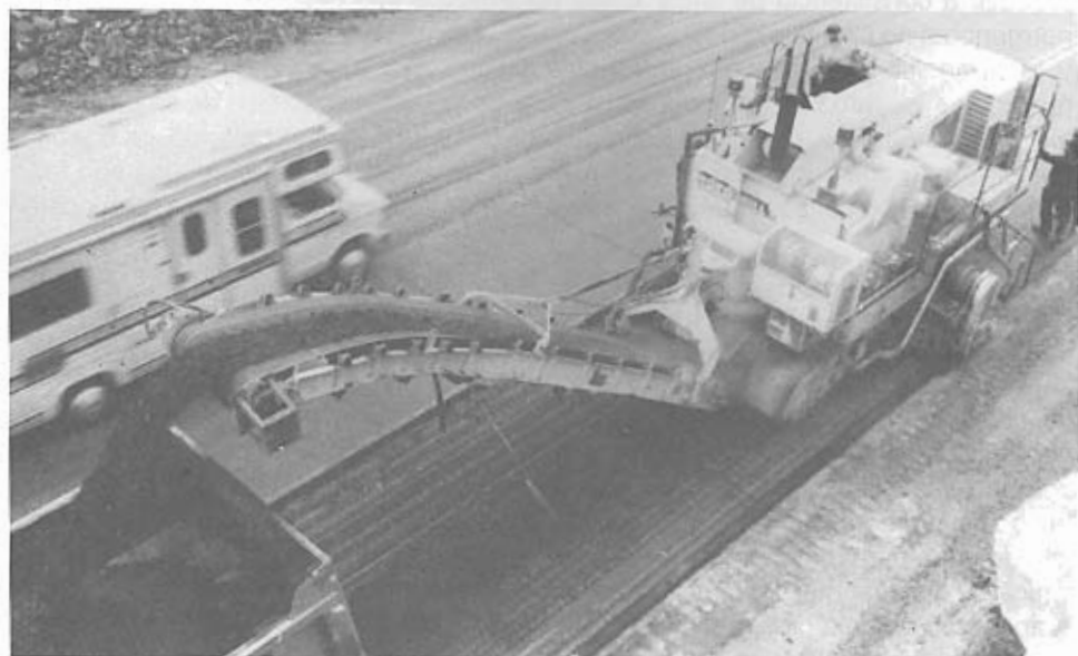
Figura 6.17 Fresagem a Frio (Cortesia de CMI Corporation)
