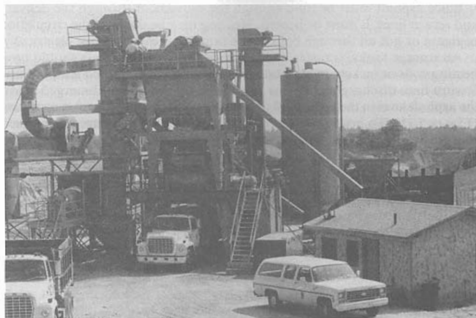
Figura 5.16 Mistura Asfáltica a Quente Carregando o Caminhão Diretamente do Malaxador (Pugmill)
